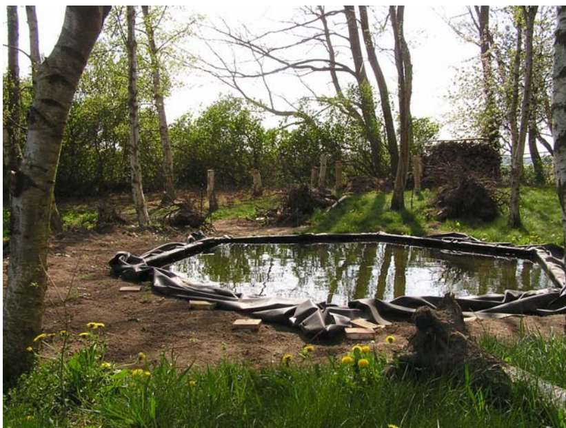
Juni 2009. Søen er fyldt med vand, der er pumpet op fra grusgravsøen, som ligger 30 meter væk. Dette er den eneste påfyldning af vand. Fremover klarer søen sig med regnvand.
